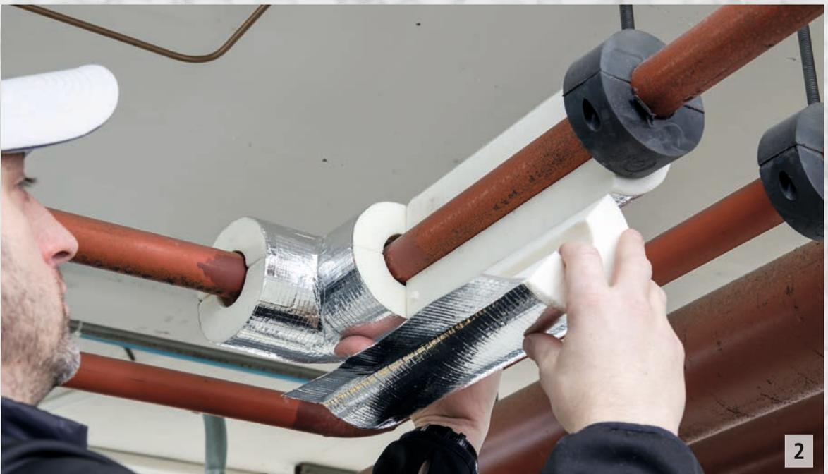
Rohrschalen mit einfachsten Hilfsmitteln (Messer) auf die gewünschte Länge zuschneiden und montieren
