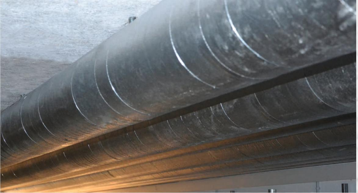
Gedämmt mit swissporKISODUR PIR Alu Grobkorn; hocheffizient und dampfdiffusionsdicht ideal für Hybridanlagen
